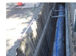
配水管布設工事
